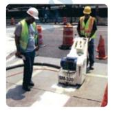
Точная корректировка поверхности в варианте с компактной сборкой алмазных дисков
